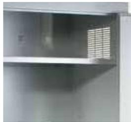
Ventilation naturelle au dos et sur les côtés hauts et bas de l'armoire.
